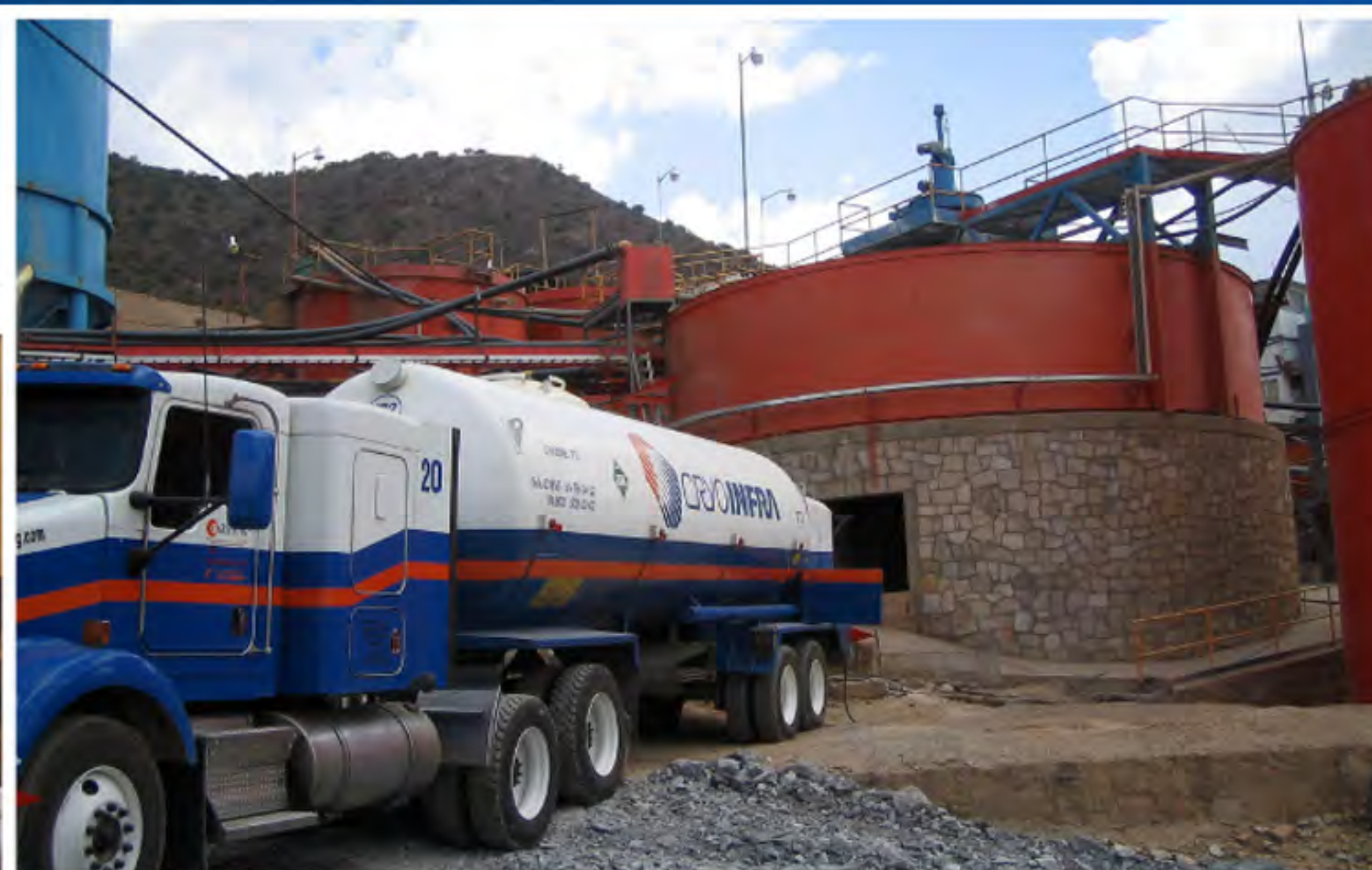
Destrucción de cianuro asistida con O_2
